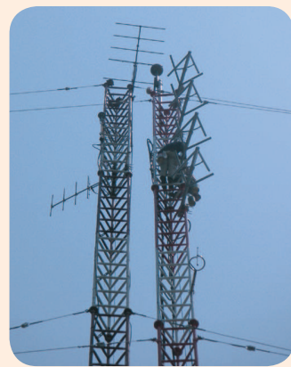
●左邊為拆卸前的天線鐵塔，右邊為新裝設的天線鐵塔，在確認新設備可以運作後，廠商才拆下舊天線鐵塔。
